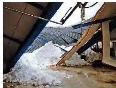
Exemples d'effondrements de toits de halles reposant sur des poutres en bois et en acier.
