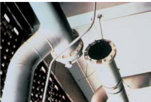
35/1 Rohrleitungen – vor allem solche mit grösseren Durchmessern – weisen eine hohe Verletzbarkeit auf, sofern sie nicht wirksam befestigt sind (San Fernando Kalifornien 1971).
