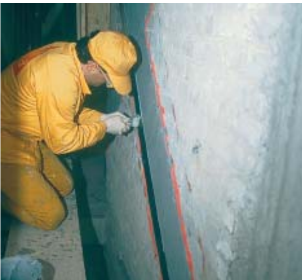
13/7 Die Lamellen müssen sorgfältig aufgeklebt und in den Geschossdecken verankert werden (Schweiz 1997).
