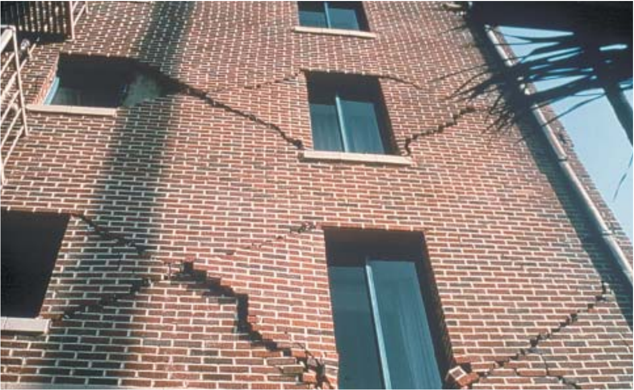
32/3 Diese Fassadenverkleidung war ungenügend verankert und nicht auf die zu erwartenden Verformungen des Tragwerks (Stahlbetonrahmen) abgestimmt (Northridge Kalifornien 1994).
