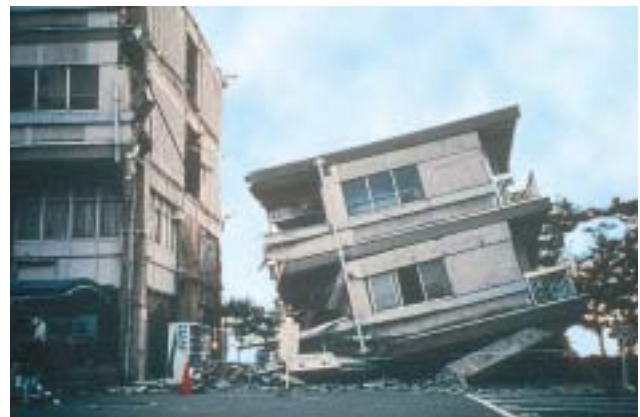
20/4 Das eingestürzte Gebäude war eine Erweiterung des älteren Gebäudes links, aber ohne genügende Fugenbreite oder – alternativ – eine feste Verbindung zu diesem. Beim Erdbeben prallte das ältere Gebäude gegen das neue und brachte es zum Einsturz (Kobe Japan 1995).
