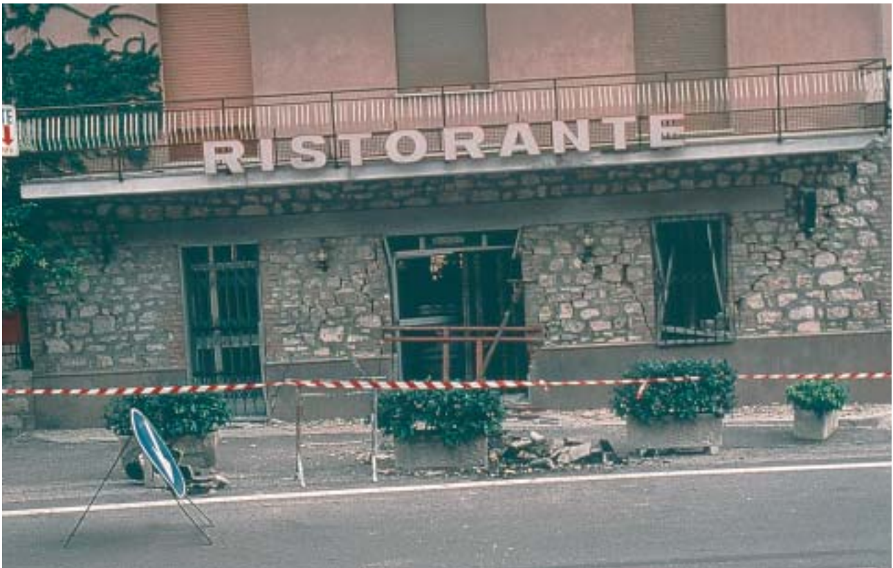
16/2 Hier wirkten die Mauerwerkspfeiler im Erdgeschoss eines Restaurants als kurze gedrungene Stützen. Sie wurden durch Schrägrisse stark beschädigt (Umbrien Italien 1997).
