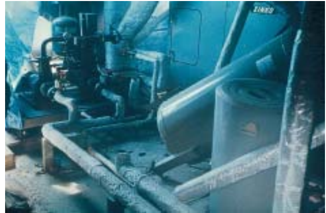
35/2 Behälter und Maschinen können umkippen, wenn sie nicht genügend verankert sind (Kobe Japan 1995).
