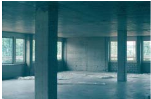
9/1 Solche Stahlbetontragwände nehmen nur geringe Teile des Grundrisses und der Fassade in Anspruch (Schweiz 1994).
