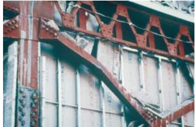
18/1 Diagonalstäbe mit Breitflanschquerschnitt sind um ihre schwache Achse geknickt ...
